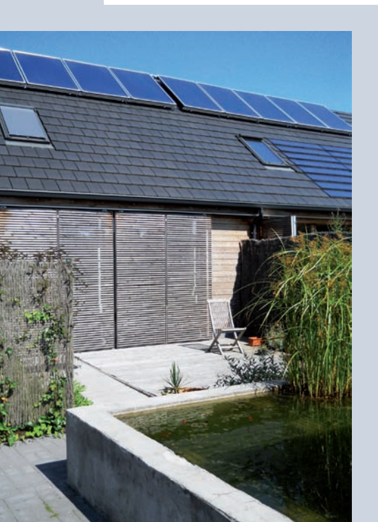
Les consommations de chauffage des logements du quartier du Pic au Vent à Tournai sont minimisées (standard passif) grâce à une isolation renforcée des parois, l'orientation et la mitoyenneté des logements. La production de chaleur est assurée en partie par des énergies renouvelables.
