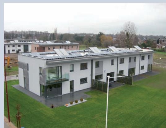
Les logements du quartier des Pléiades à Visé ont des besoins de chauffage inférieurs à 30 kWh/m 2 .an. Des sources d'énergies renouvelables sont mobilisées pour la production de chaleur du quartier : chaudière biomasse à pellets et capteurs solaires thermiques, ce qui permet d'atteindre l'autonomie en été.
