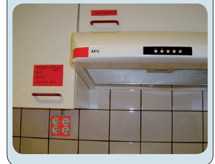
Contrastes de couleurs des commandes et poignées par rapport à leur environnement.
