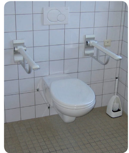
Placement de barres d'appui dans W.-C. adapté.
