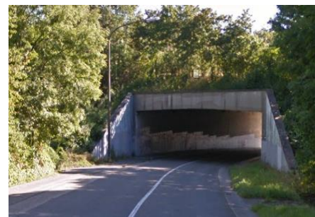
Tunnel rue Thier de Hodimont sous l'E42
