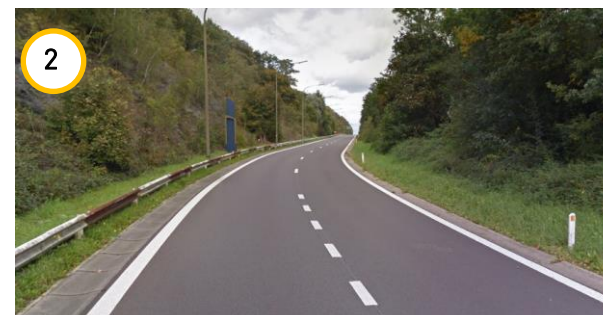
Massif rocheux le long de la bretelle
