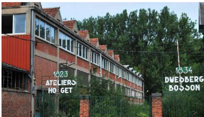
Vue sur l'entrée du site (date inconnue)
