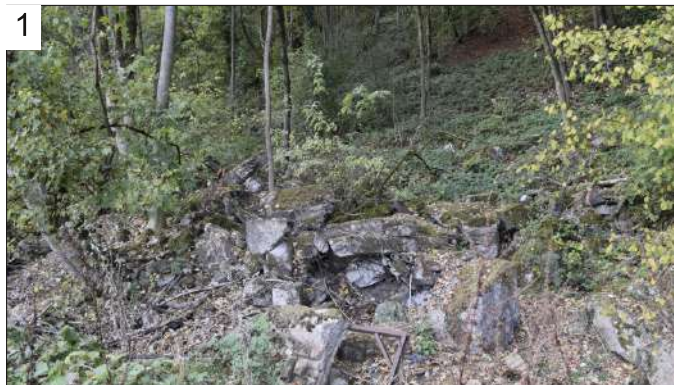
Débris des remblais au bas du versant en rive droite
