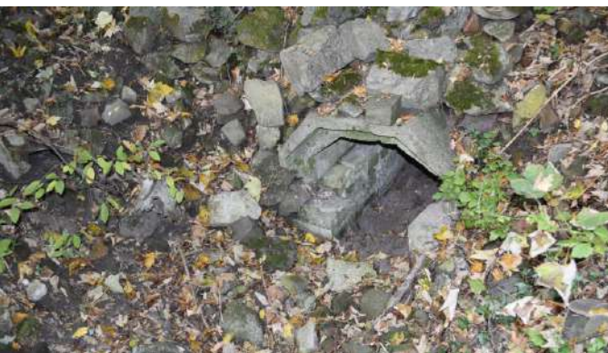
Canalisations de l'ancien ruisseau
