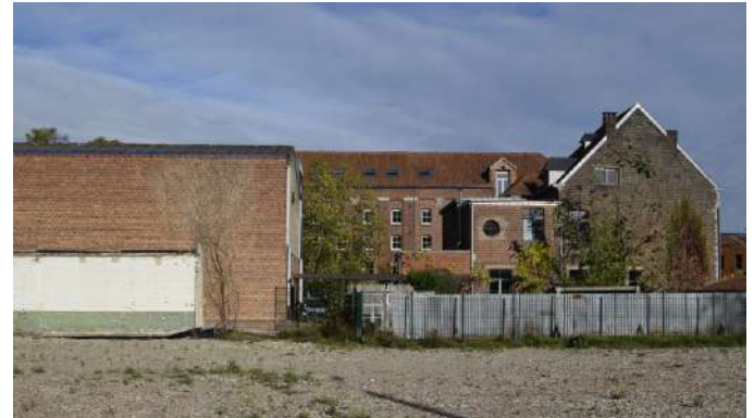
Halles industrielles reconverties en habitations
