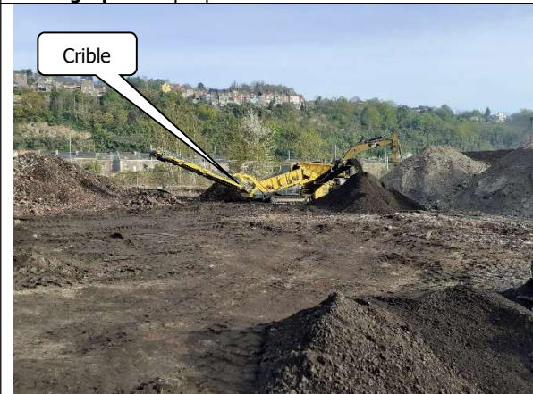
Photographie 7: criblage des différents lots avant évacuation vers la filière adéquate
