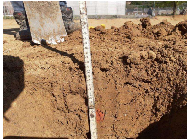
Photographie 39: confinement avec minimum 50 cm de terres saines
