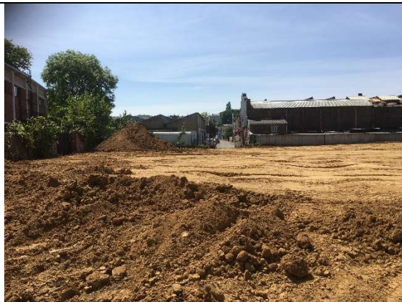
Photographie 26: confinement avec minimum 50 cm de terres saines
