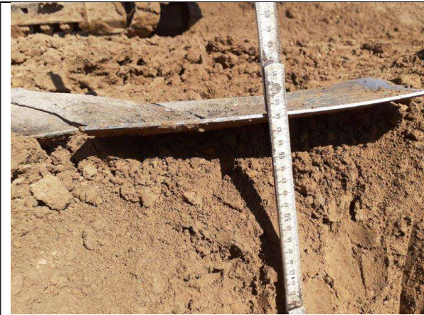
Photographie 38: confinement avec minimum 50 cm de terres saines
