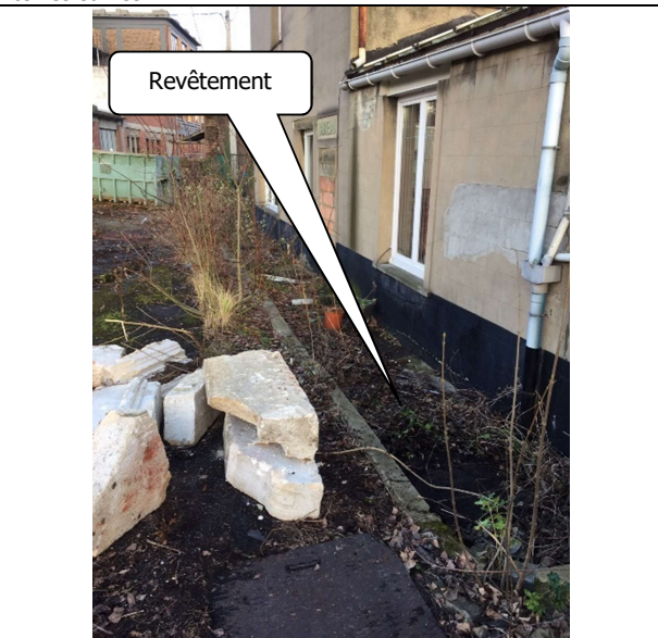
Photographie 43: dallage en béton recouvert de mousse laissé en place le long de l'habitation (égout sous ce revêtement)
