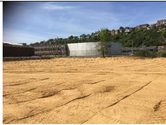
Photographie 27: confinement avec minimum 50 cm de terres saines
