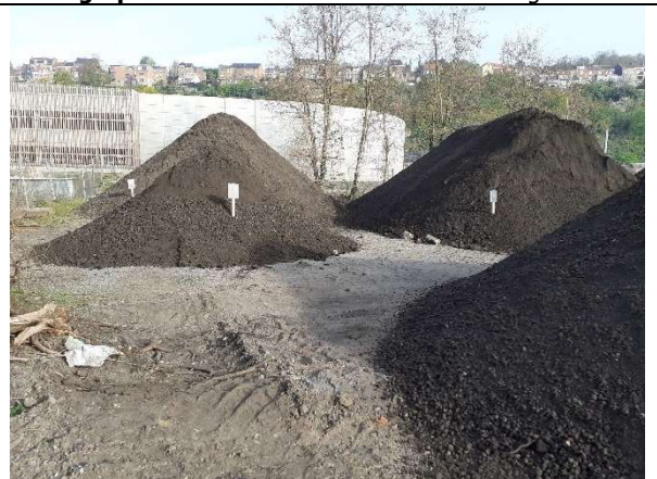
Photographie 8: terres criblées dans l'attente de leur évacuation
