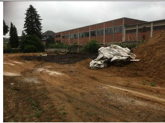
Photographie 31: excavation des terres amiantées le 06 juillet 2020
