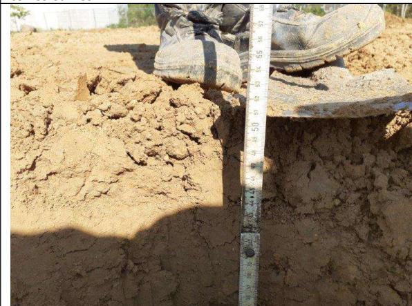
Photographie 40: confinement avec minimum 50 cm de terres saines
