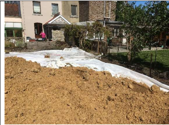
Photographie 24: confinement avec minimum 50 cm de terres saines
