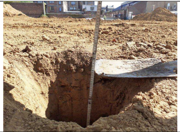
Photographie 41: confinement avec minimum 50 cm de terres saines
