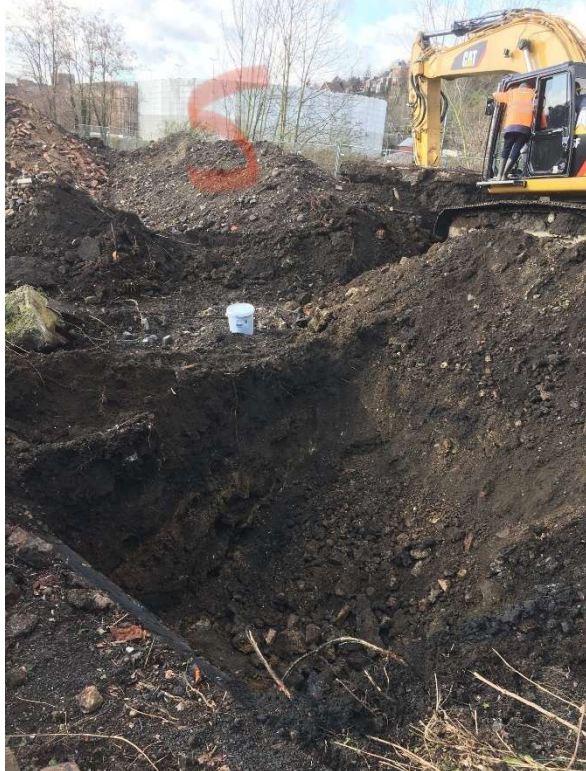
Photographie 3: fouille 5 réalisée dans le lot 2
