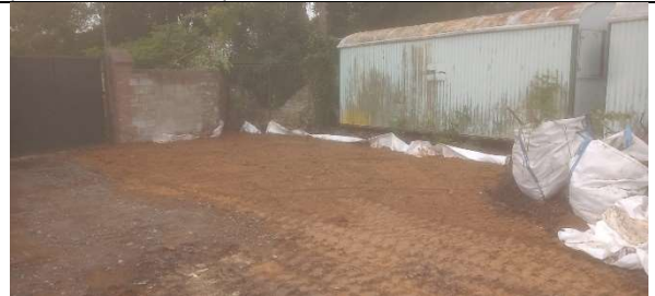
Photographie 37: confinement avec minimum 50 cm de terres saines
