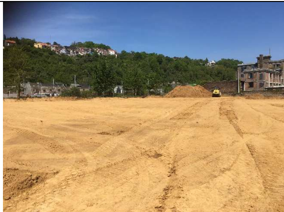
Photographie 28: confinement avec minimum 50 cm de terres saines
