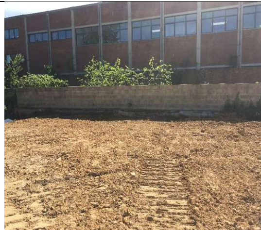
Photographie 25: confinement avec minimum 50 cm de terres saines
