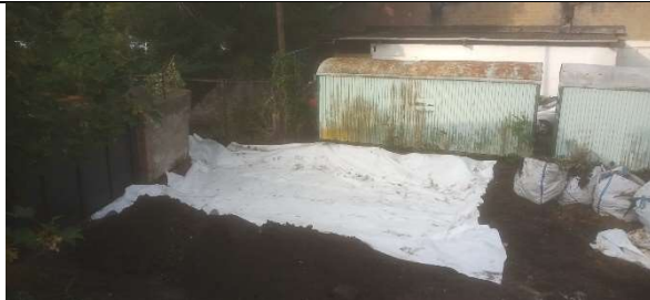
Photographie 36: pose du géotextile sur la zone impactée par la renouée du Japon
